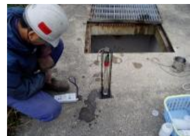
浄化槽点検作業
